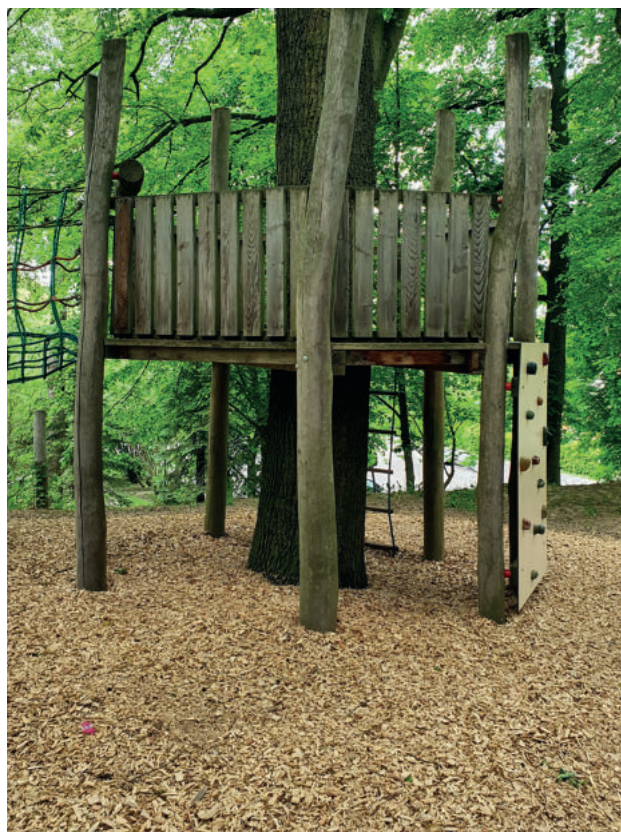
Bei offenen Konstruktionen (z. B. Plattform um den Baum) ist es wichtig, dass es vom Baumhaus aus nicht möglich ist, direkt auf den Baum zu klettern. Aus diesem Grund muss der Abstand von der Standfläche bis zum nächsten Ast mind. 2,5 m betragen.
