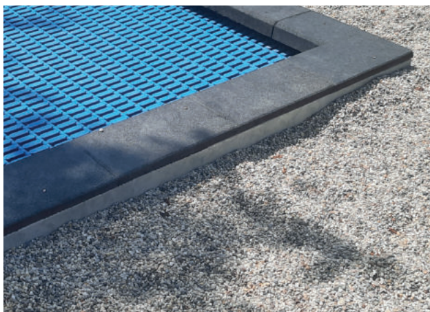
In diesem Fall wäre starrer Fallschutz besser, denn bei losem Fallschutz werden die Kanten des Bodentrampolins freigespielt und stellen somit ein Verletzungsrisiko dar.
