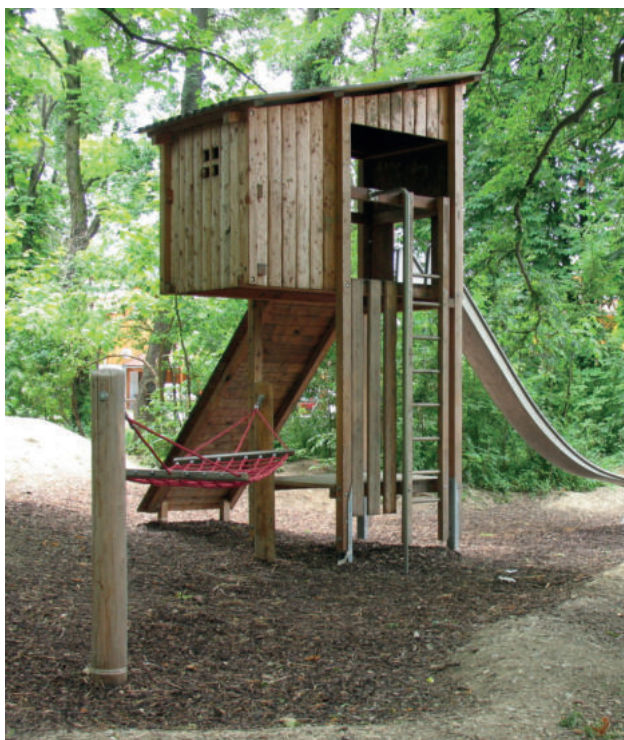
Baumhäuser müssen so platziert werden, dass sie einerseits den Baum nicht schädigen und andererseits die Forderungen der EN 1176 hinsichtlich Sicherheit erfüllen.
