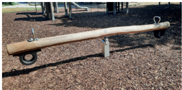
Wippen, die nur im Sitzen genutzt werden können, haben einen verringerten Fallschutzbereich (1 m rundumlaufend)
