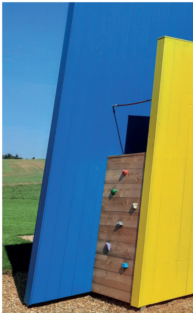
Einstiege (z. B. auf eine Plattform mittels Leiter oder Netz) dürfen max. 120cm breit sein und müssen über eine Absturzsicherung verfügen. Bei Unterbrechungen unter 50 cm Breite kann diese entfallen.
