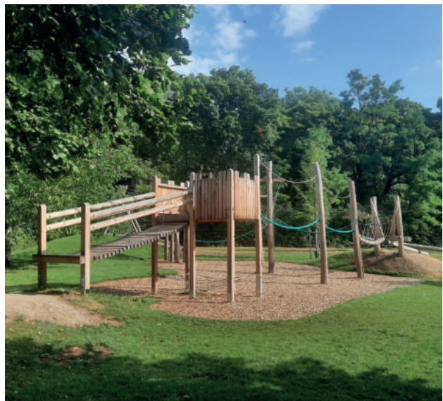
Dieses Spielgerät bzw. Teile davon sind nicht für kleinere Kinder gedacht. Der Eingang ist daher schwer zugänglich ausgeführt.
