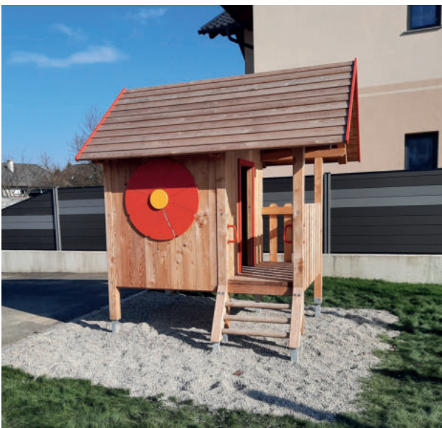
Die leichte Zugänglichkeit über den niedrigen Einstieg, Fallhöhe unter 2 m und die Brüstung bereits ab 60 cm Fallhöhe zeichnen typische Spielgeräte für Kleinkinder aus.
