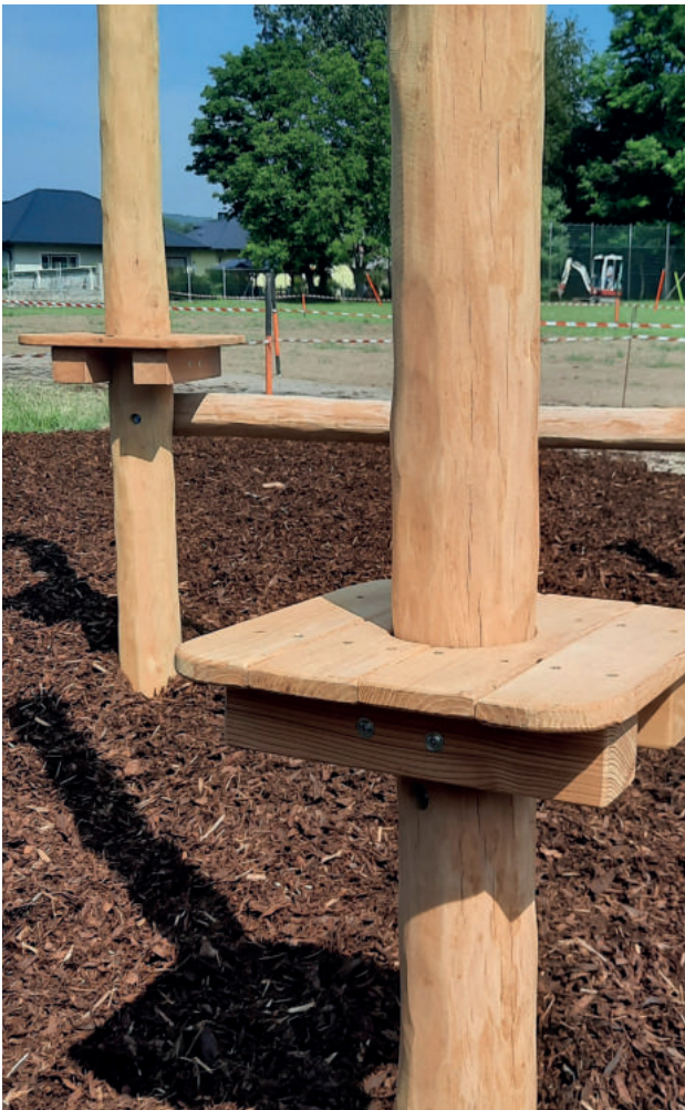
Eine Ausnahme bilden sehr kleine Stehflächen, auf denen man sich nur durch Festhalten, z. B. an einem Steher, aufhalten kann. Man geht davon aus, dass hier der Steher die Funktion eines Geländers übernimmt.
